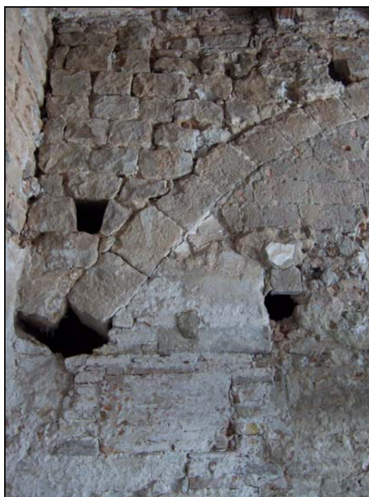
Banda nord de l'arc UE 107.
