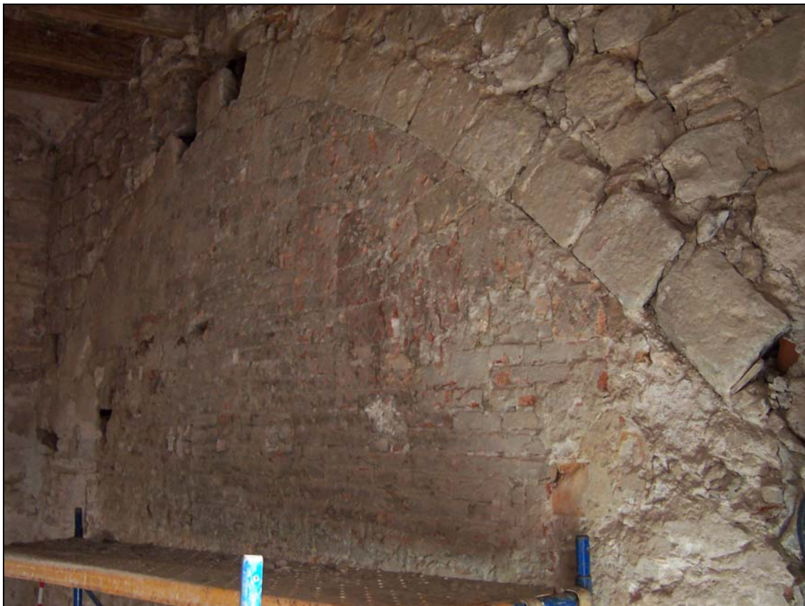
General final de l'estat de l'arc UE 107, una vegada acabat el seu repicat.
