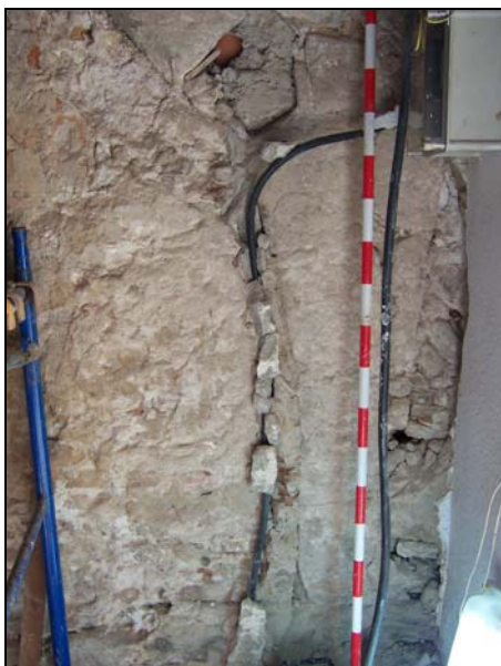
Detall de l'arrancament sud de l'arc UE 107.
